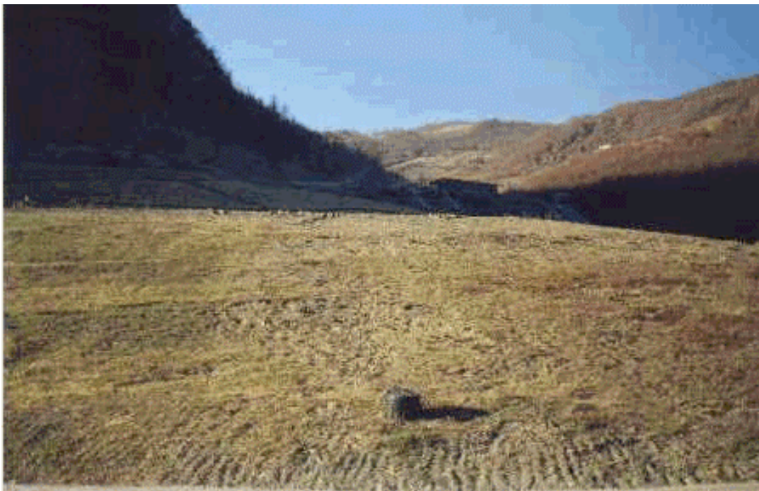
Veduta della discarica – copertura ultimata
