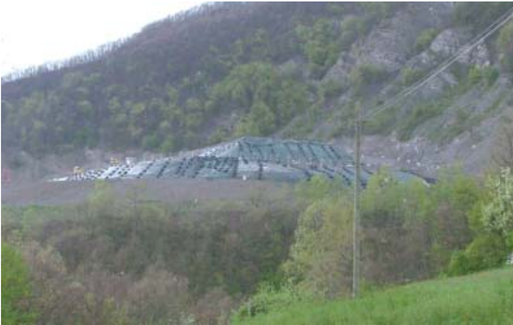
Veduta della discarica – messa in opera dei teli
